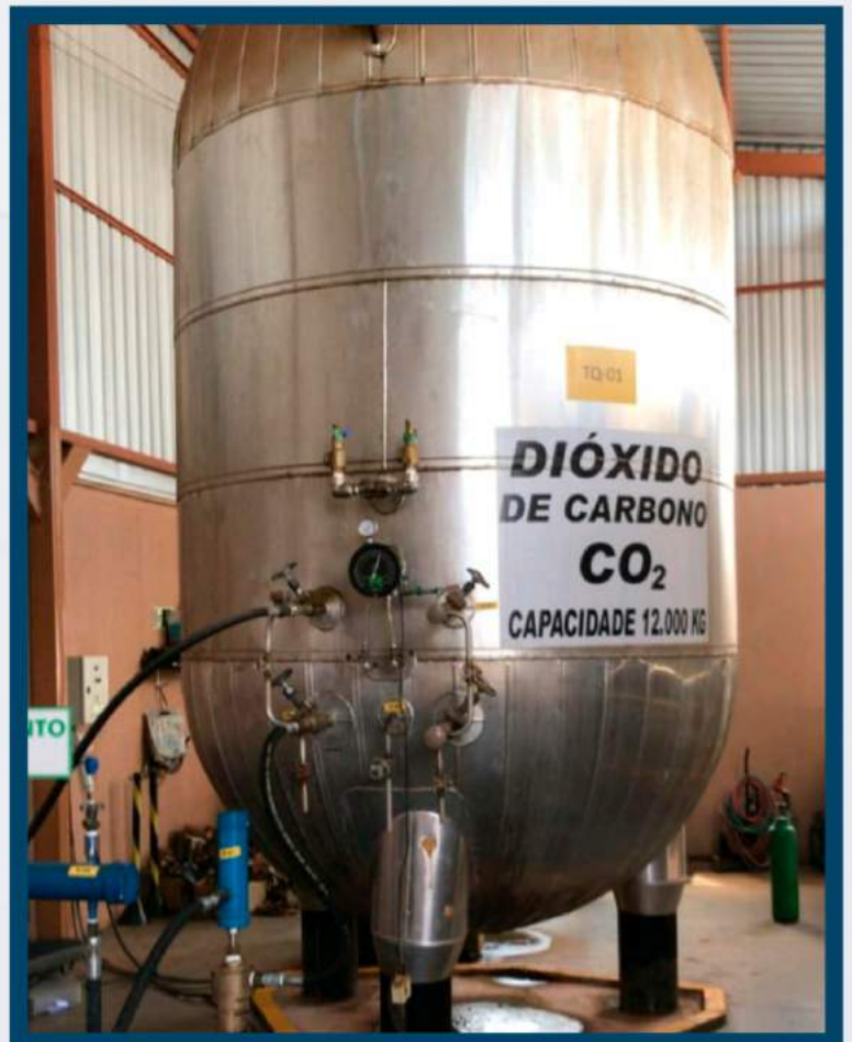
INSTALAÇÃO DE TANQUE DE DIÓXIDO DE CARBONO
