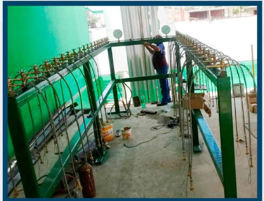
INSTALAÇÃO DE RAMPA DE ENCHIMENTO DE GASES DO AR
